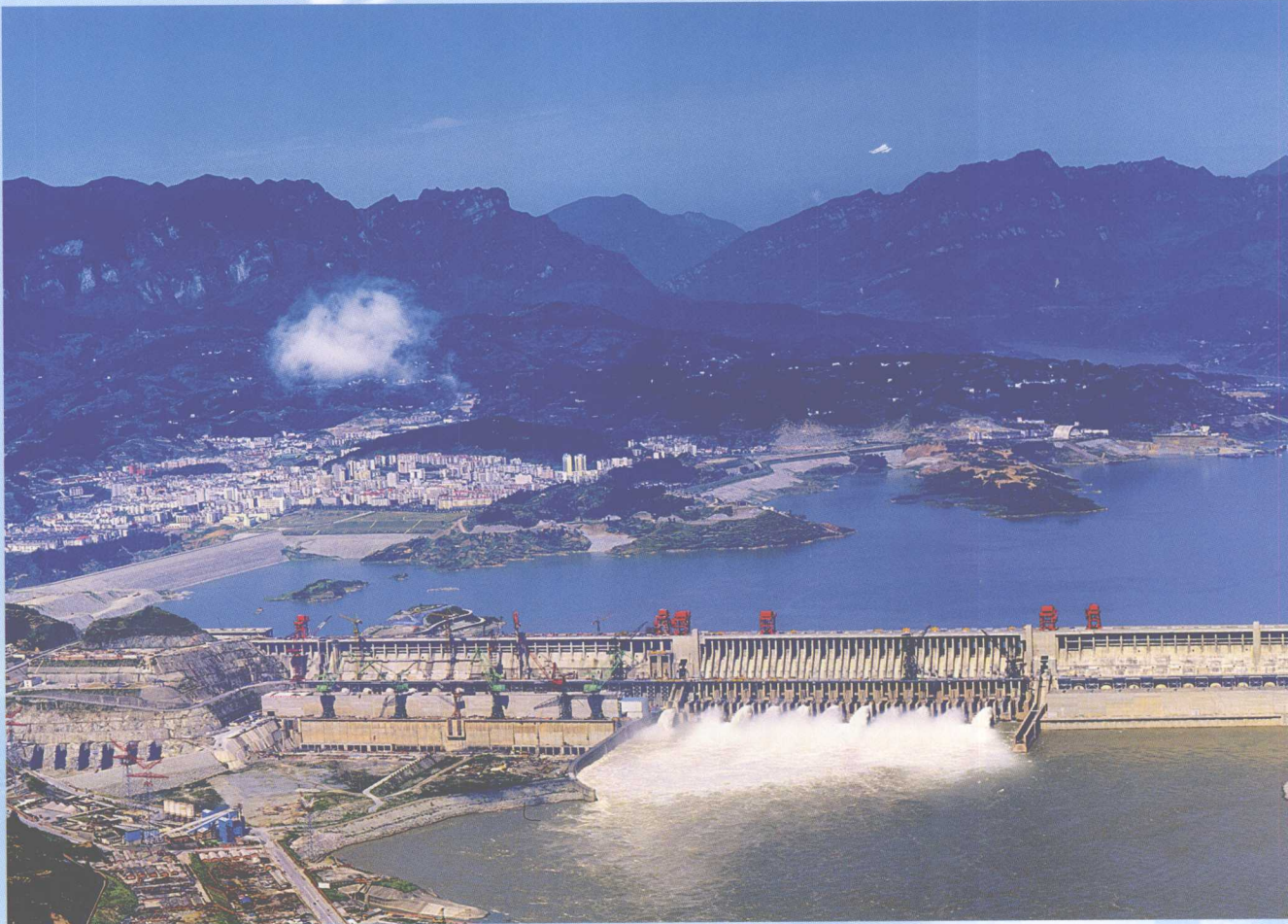
三峡大坝全景
