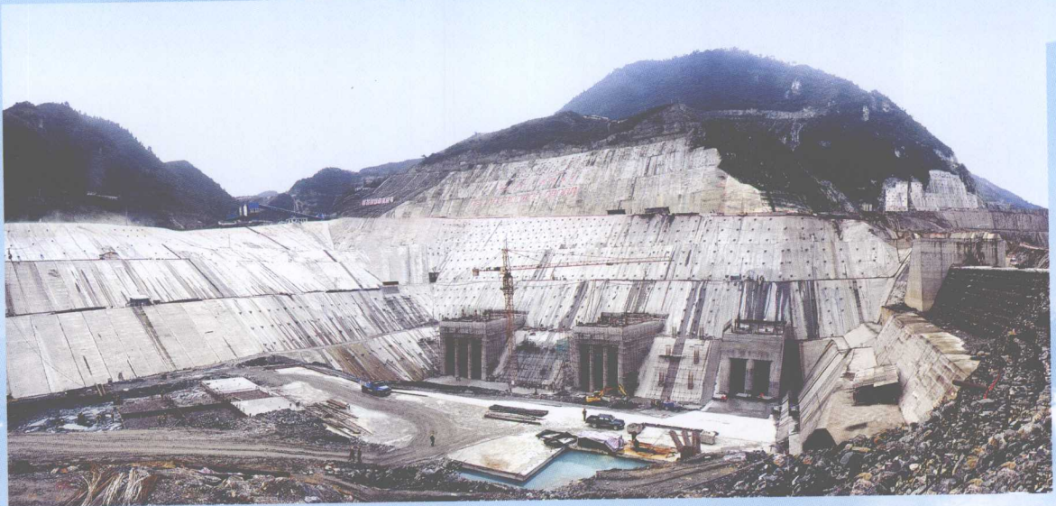
贵州构皮滩水电站尾水边坡处理
