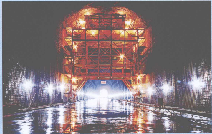
溪洛渡水电站左岸导流洞施工现场
