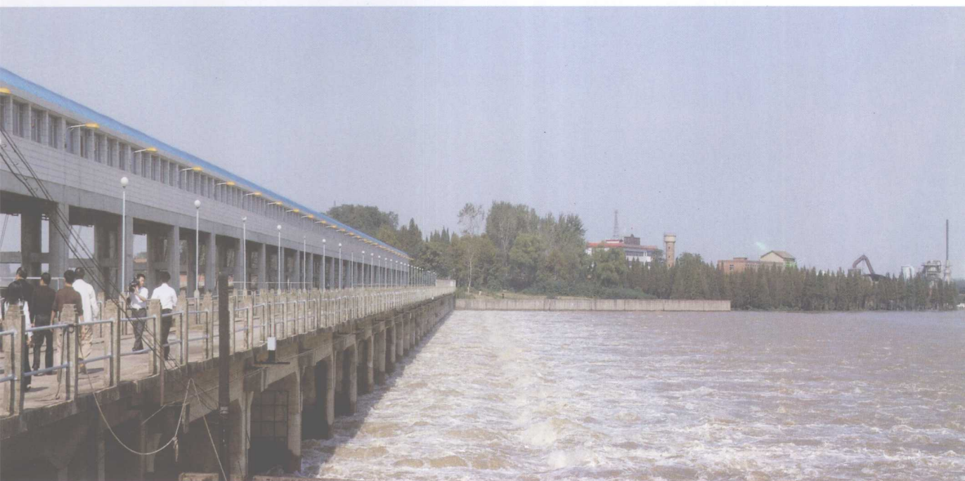
杜家台分洪闸分洪
