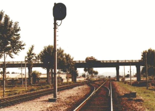
京沈(南)公路沙河驿跨线桥
