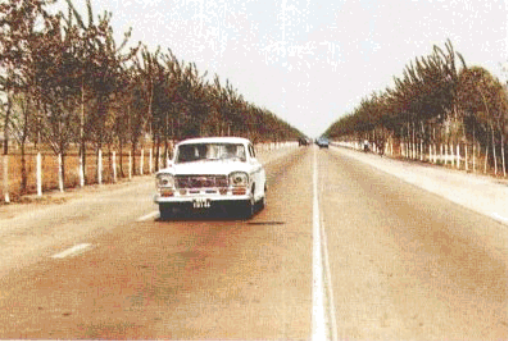
津秦公路丰南段水泥混凝土路
