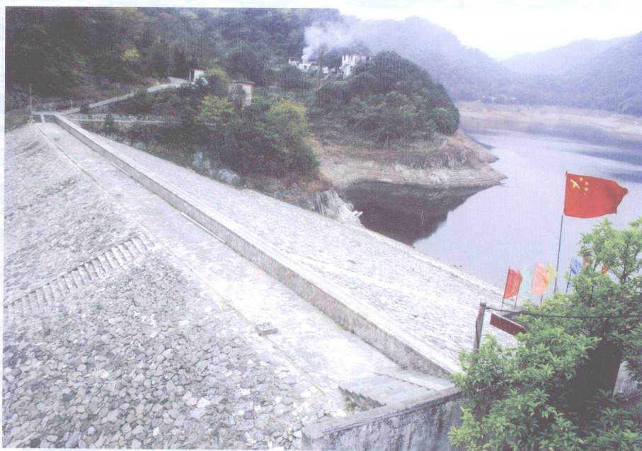
仰义水库大坝
