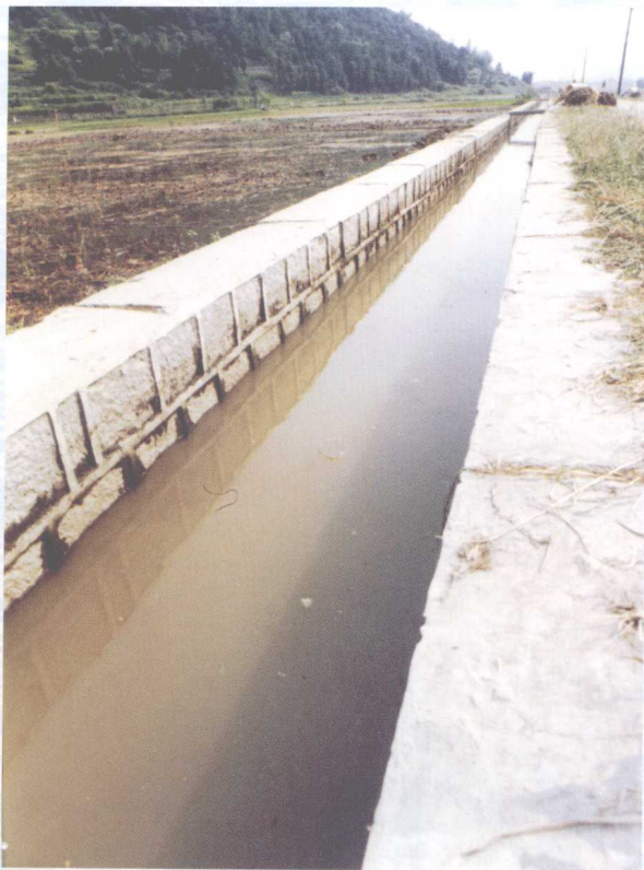
▲ 浆砌块石水泥勾缝渠道
