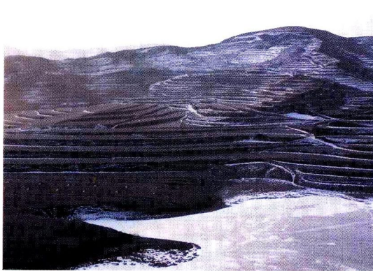
6.城关镇何家庄滑坡及滑坡体堵塞形成的堰塞湖
