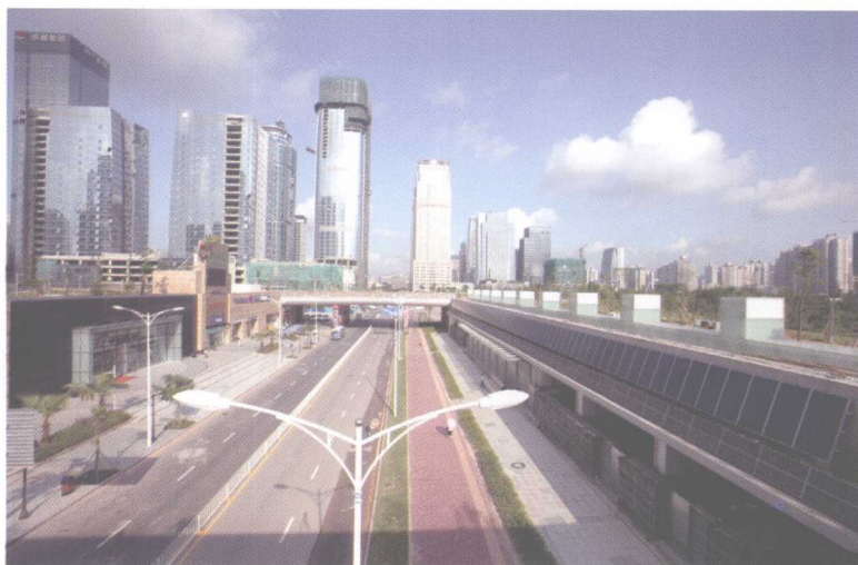
尚德为深圳中心广场安装的 21.6 千瓦独立光伏系统
