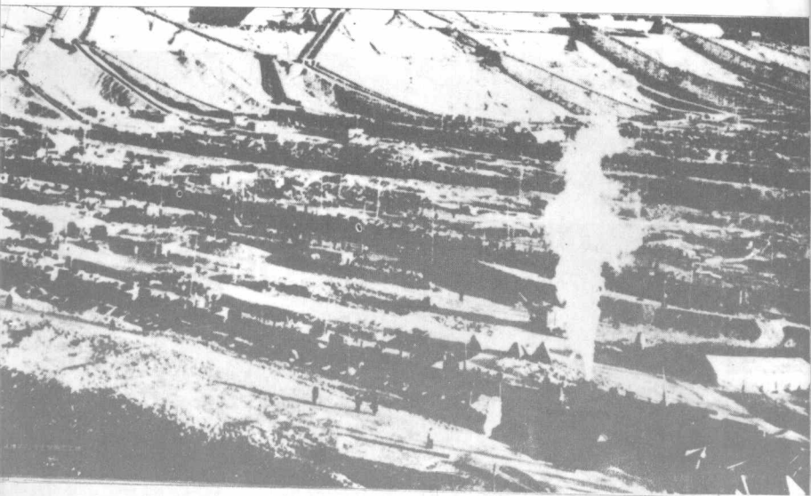
沸腾的白河主坝施工工地。
