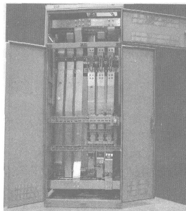
图 1-5-2 固定封闭式开关柜内部结构图示（一）
