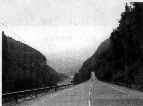
图 1-6 坡顶缺乏警告标志
