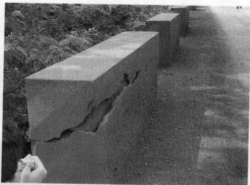
图 1-2 间断布置的砌体防撞设施
