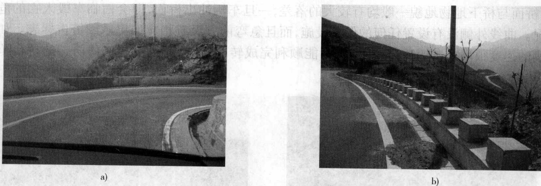
图 1-1 直墙式混凝土防撞护栏
