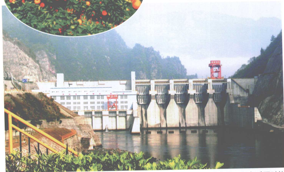
总库容3.28亿立方米，装机3台，总容量24万千瓦，年平均发电量7.92亿千瓦时的 碗米坡水电站。
