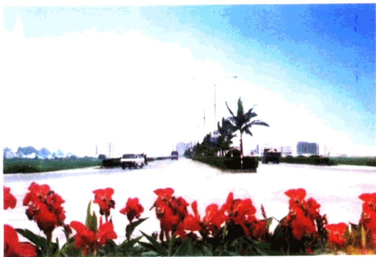
▲ 新兴县公路建设, 图为县城新洲大道
