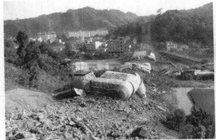
图 1-3 湖南省湘西自治州凤凰县堤溪沅江大桥“8·13”特别重大坍塌
