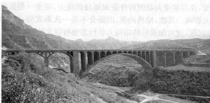
图 1-6 丹河大桥全貌
