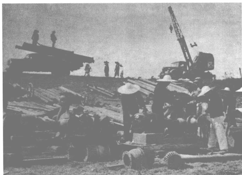
防汛人员正在张公堤排水工地吊卸和安装抽水机。
