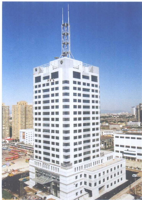
荣获“鲁班奖”的北京公交运营调度指挥中心工程
