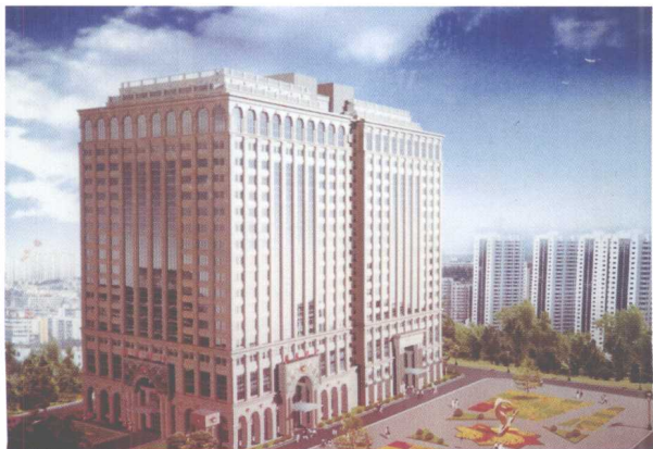
在施工的北京国际新闻文化中心工程
