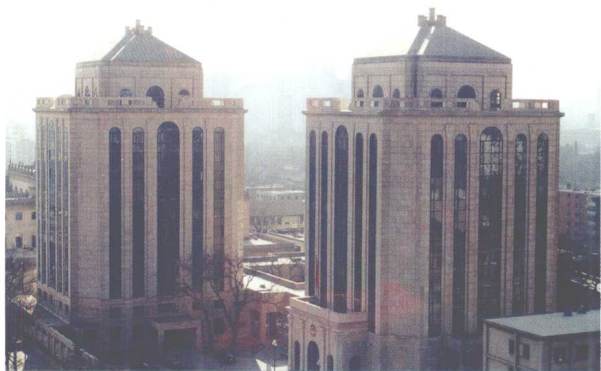
荣获“鲁班奖”的全国政协办公楼工程
