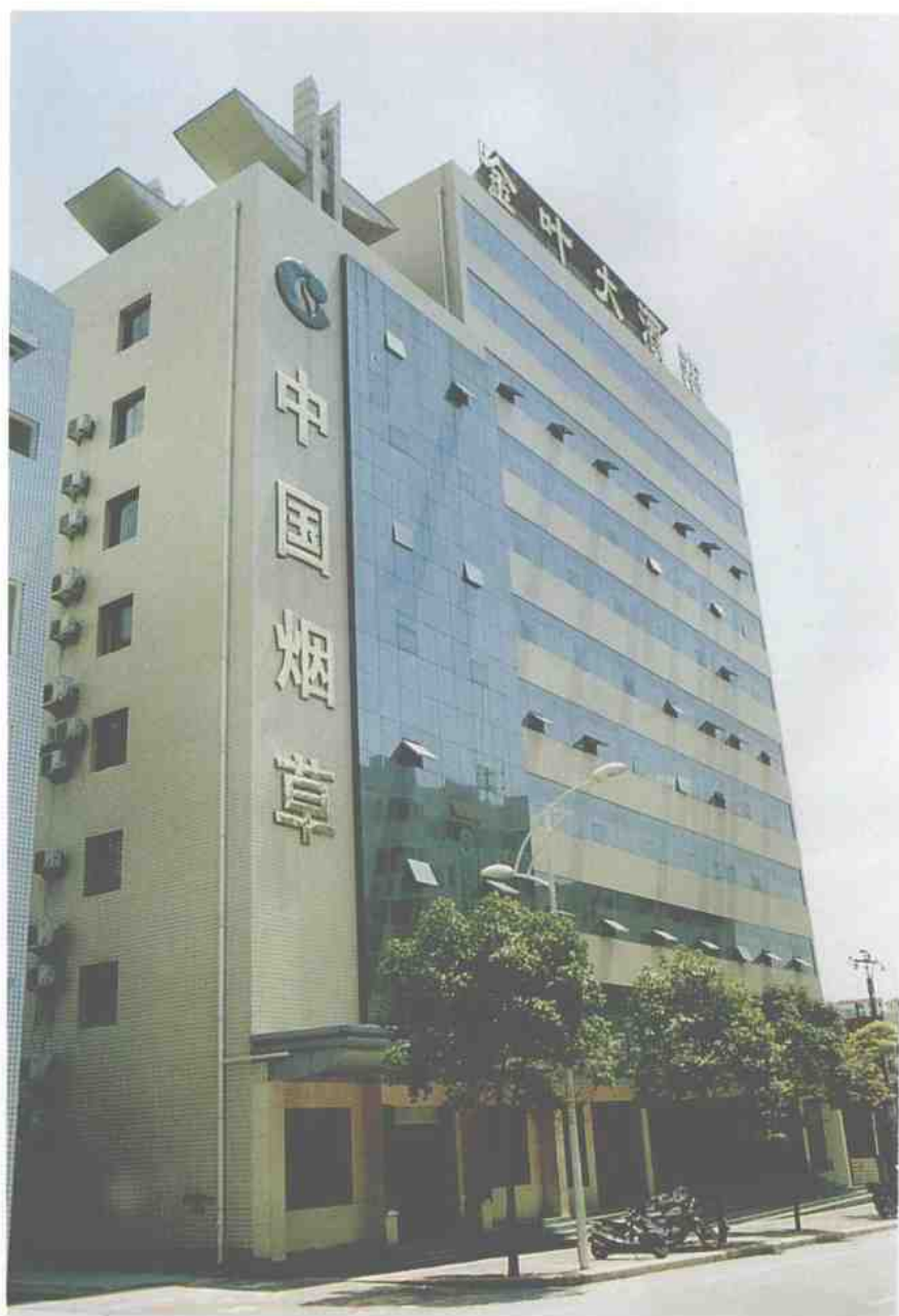
■ 郟县烟草专卖局(公司)综合楼(摄于2005年6月)
