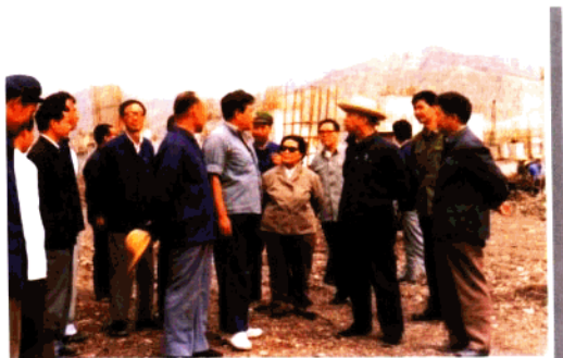
1983年8月在大武口 电厂工地上
