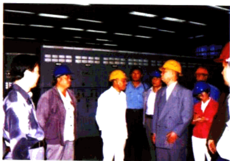
参观新疆玛纳斯电厂 中心控制室
