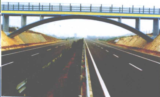
图 4-7 上跨桥和涂装工艺
