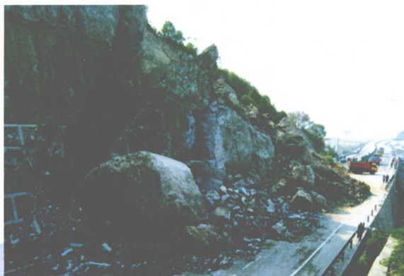
图 2-4 甬台温高速公路乐清段山体崩塌
