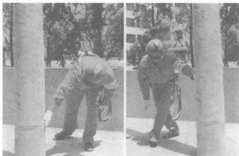
图 1-1-4 电杆杆根检查
