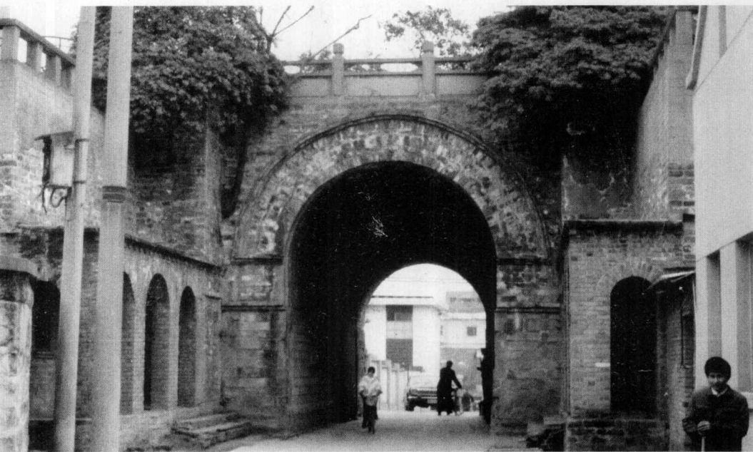
成都北较场城墙门洞。(胥昌同 摄)
