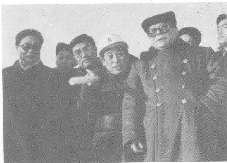
一九九〇年元月二十一日中共中央总书记江泽民同志视察平朔露天煤矿
