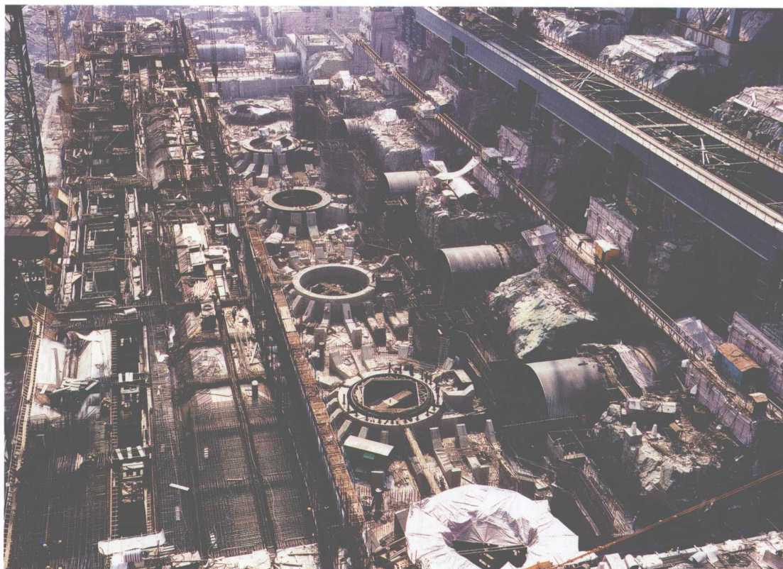
左岸厂房混凝土施工
