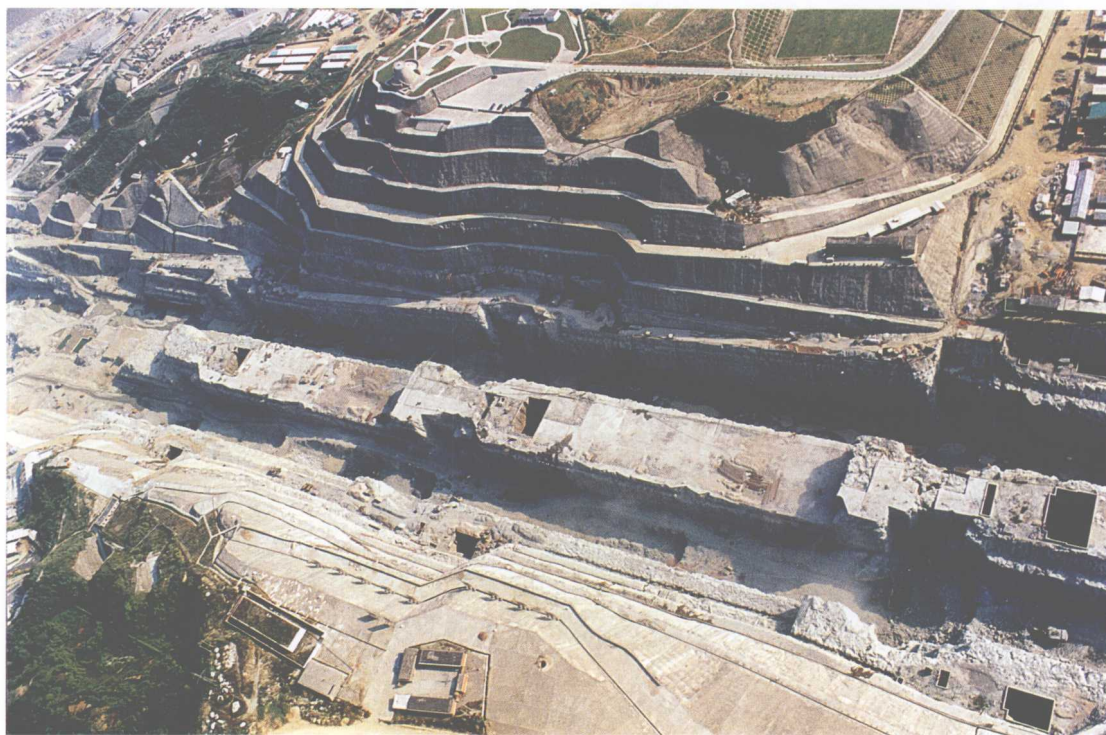
双线五级船闸开挖鸟瞰图
