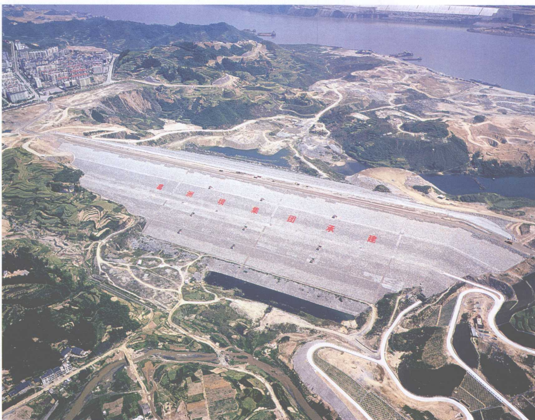
茅坪溪防护大坝全景
