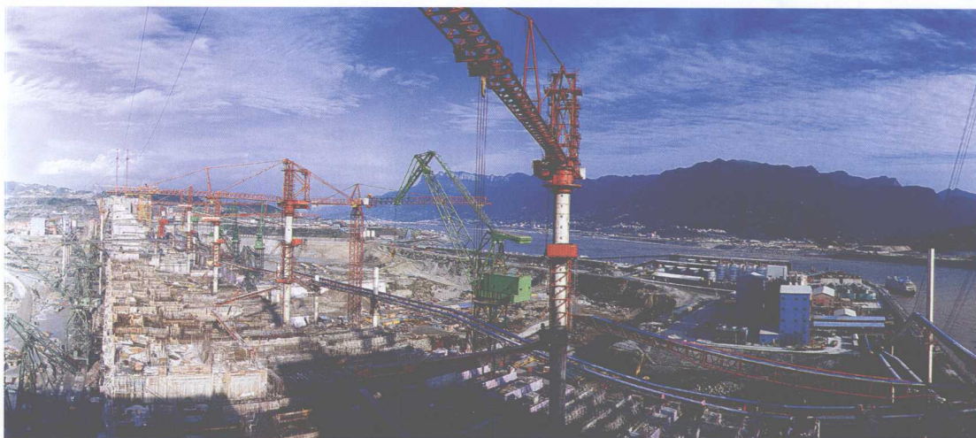
左岸大坝施工全景
