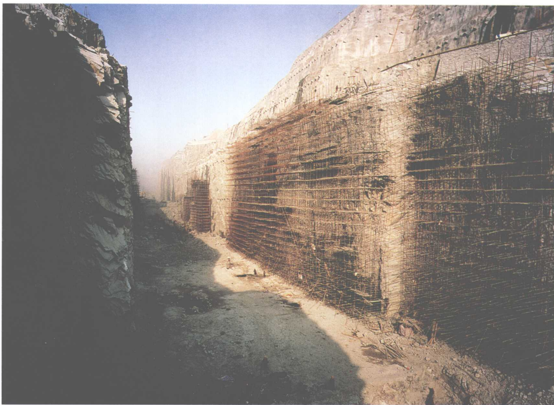
船闸直立边坡与高强结构锚杆
