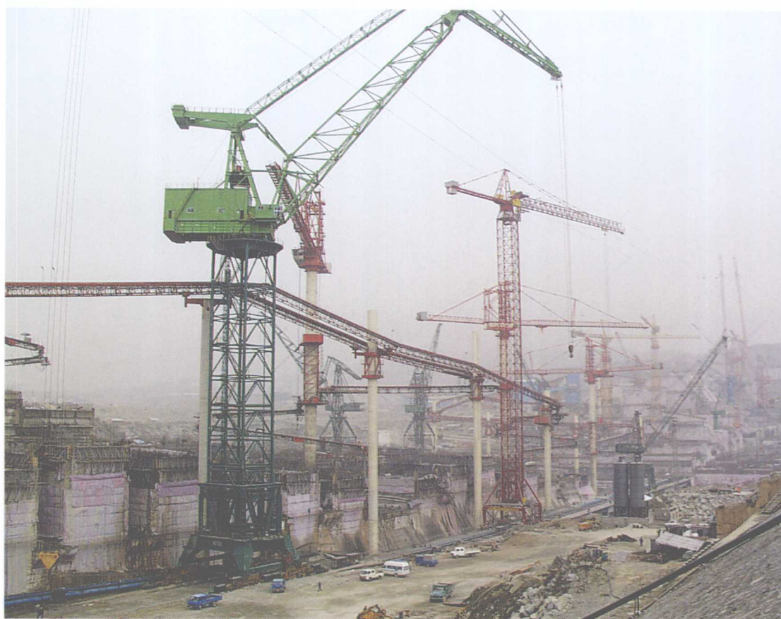
大坝初期混凝土浇筑
