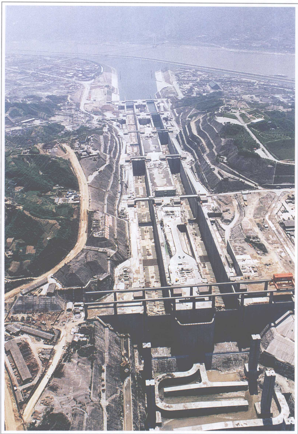
双线五级船闸全景
