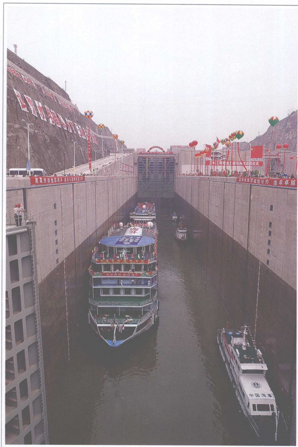
双线五级船闸成功按期实现试通航
