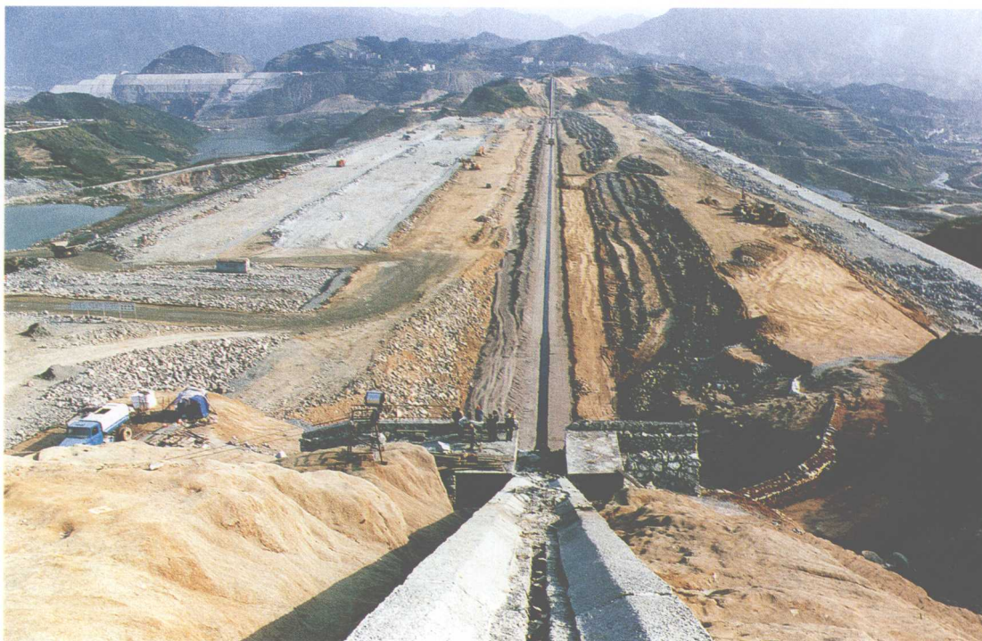
茅坪溪防护大坝沥青混凝土心墙施工
