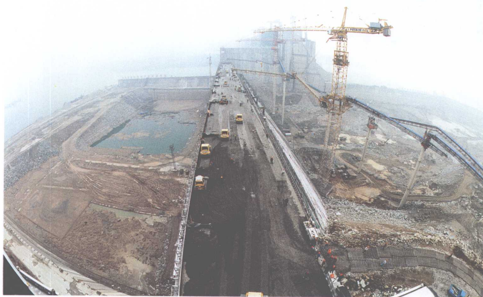
三期碾压混凝土围堰施工全景
