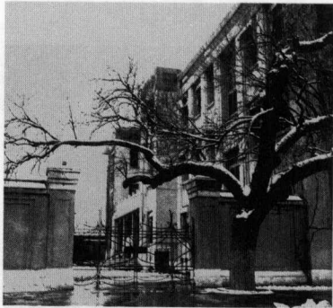
I-7-1 日伪建设总署侧面大门
