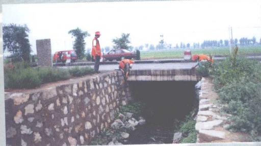
山西省公路普查工作人员正在采集 公路涵洞基础资料
