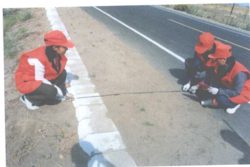
内蒙古自治区公路普查工作人员正 在采集公路基础资料
