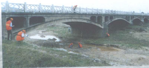
陕西省公路普查工作人员正在采集 桥梁基础资料
