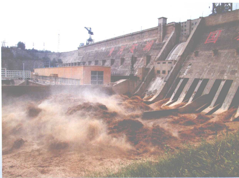
三门峡水库泄洪排沙 (黄委防办供稿)
