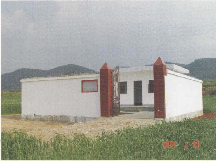
◆ 大兴堡深井泵房
