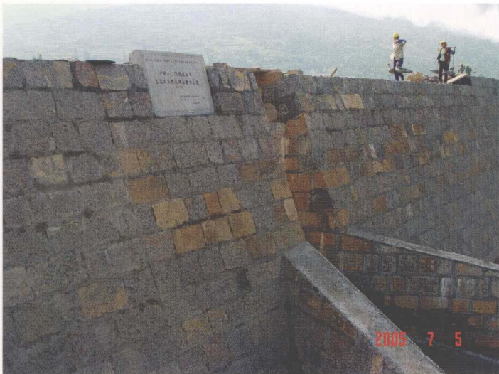
◆ 皮家寨岩溶大泉束流调压壅水工程地上束流调压池 (工程名称由王梓澈书写)
