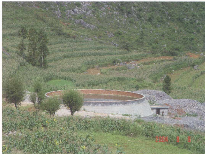
◆ 湾半孔表层泉蓄引工程的调蓄水池
