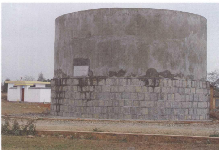
◆ 大衣村深井调节水池
