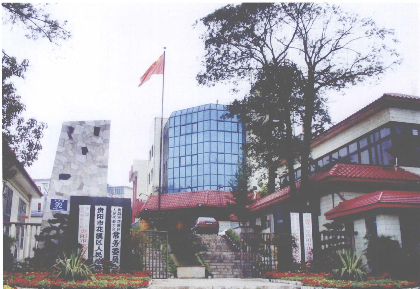
20 世纪 90 年代初建成的中共花溪区委、区人大、区政府、区政协办公大楼（贵筑路 92 号）
