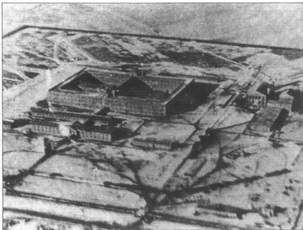
建设中的“口”字楼及总务部大楼
