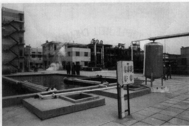
厂区一角 污水闭路循环池
