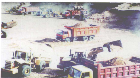
投资260亿元的鄂尔多斯煤转油项目一期工程施工现场
