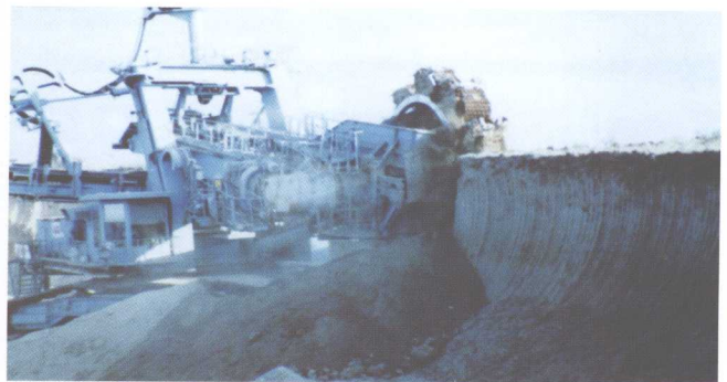
准格尔露天煤田剥离开采现场
