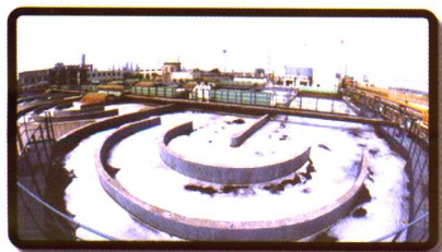
■ 污水处理场系统
