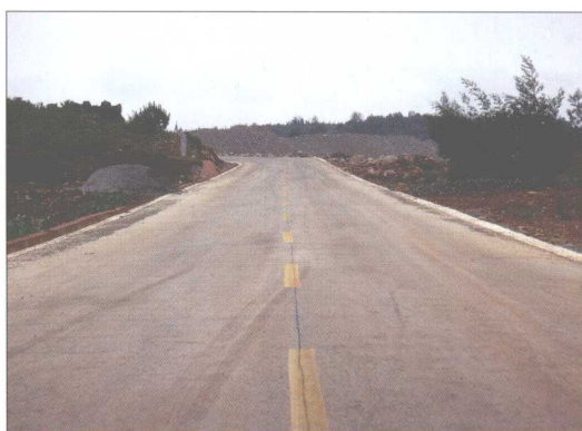
(十六) 昆明市双哨公路复合式碾压混凝土路面
