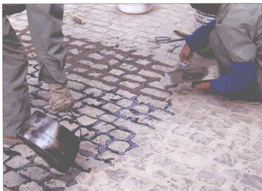
(二十五) 昆明市吴井路整齐块石路面乳化沥青勾缝施工
