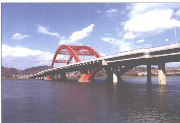
(四十一) 昆明市高海公路跨海大桥
