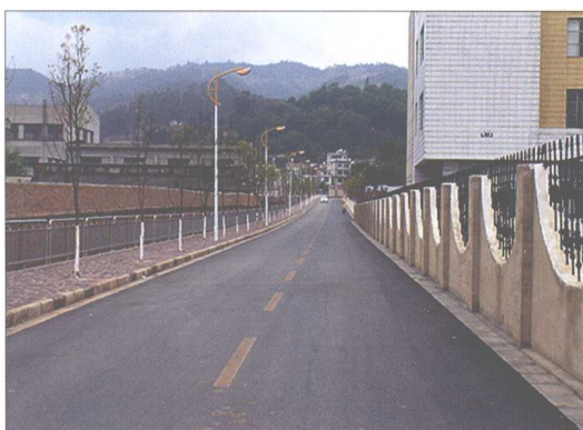
(十五) 昆明市西山区马街上村道路半刚性基层倒装结构路面
