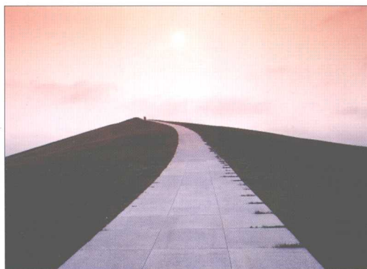
(二十三) 摊铺切开型混凝土路面 (先浇注后切割)
