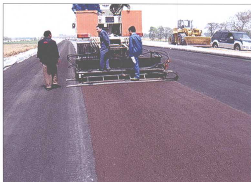
(二) 稀浆封层路面施工
