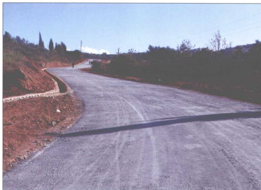
(十九) 已基本完工的昆明市双哨公路复合式碾压混凝土路面
