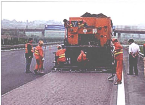
(一) 路面微表处施工
