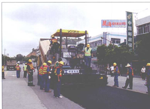
(五) 超薄沥青磨耗层
