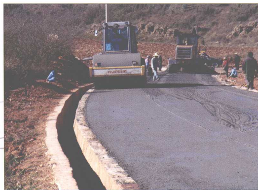
(十八) 正在施工的昆明市双哨公路复合式碾压混凝土路面实验路段
