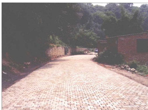
(二十一) 昆明市西山区观音山混凝土预制块路面
