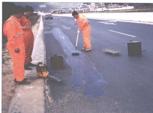
(十) “沥再生”施工照片
