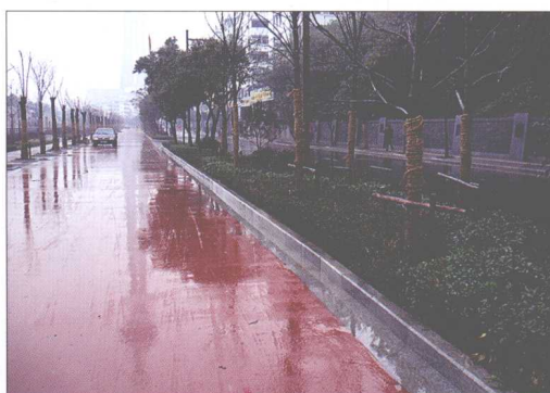
(四) 彩色沥青混凝土路面
