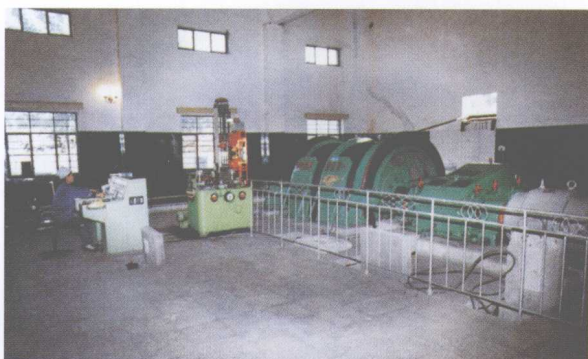
新登煤矿2米运输绞车房
