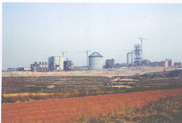
新登集团水泥厂建设工地
