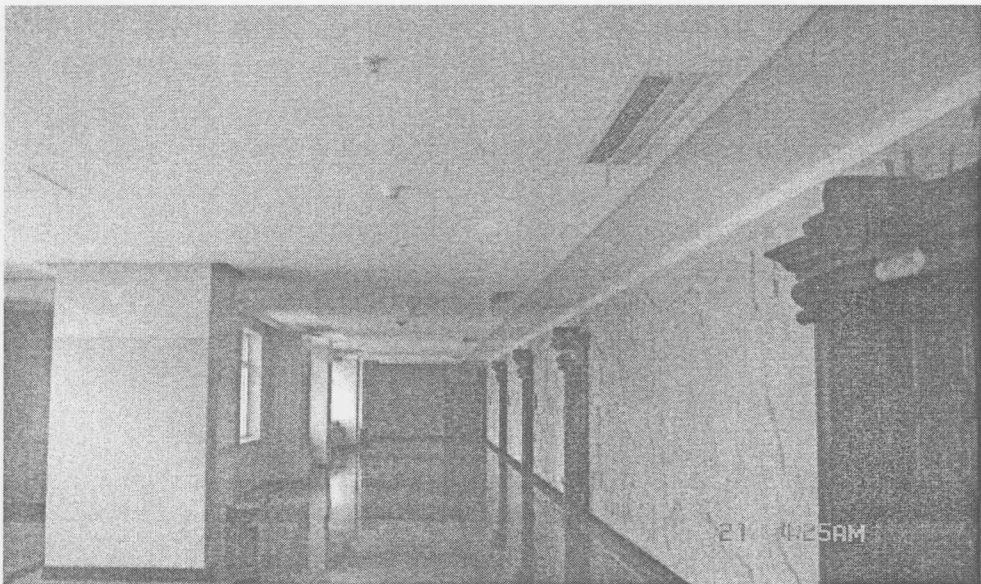
图 1-4 金属明龙骨吊顶
