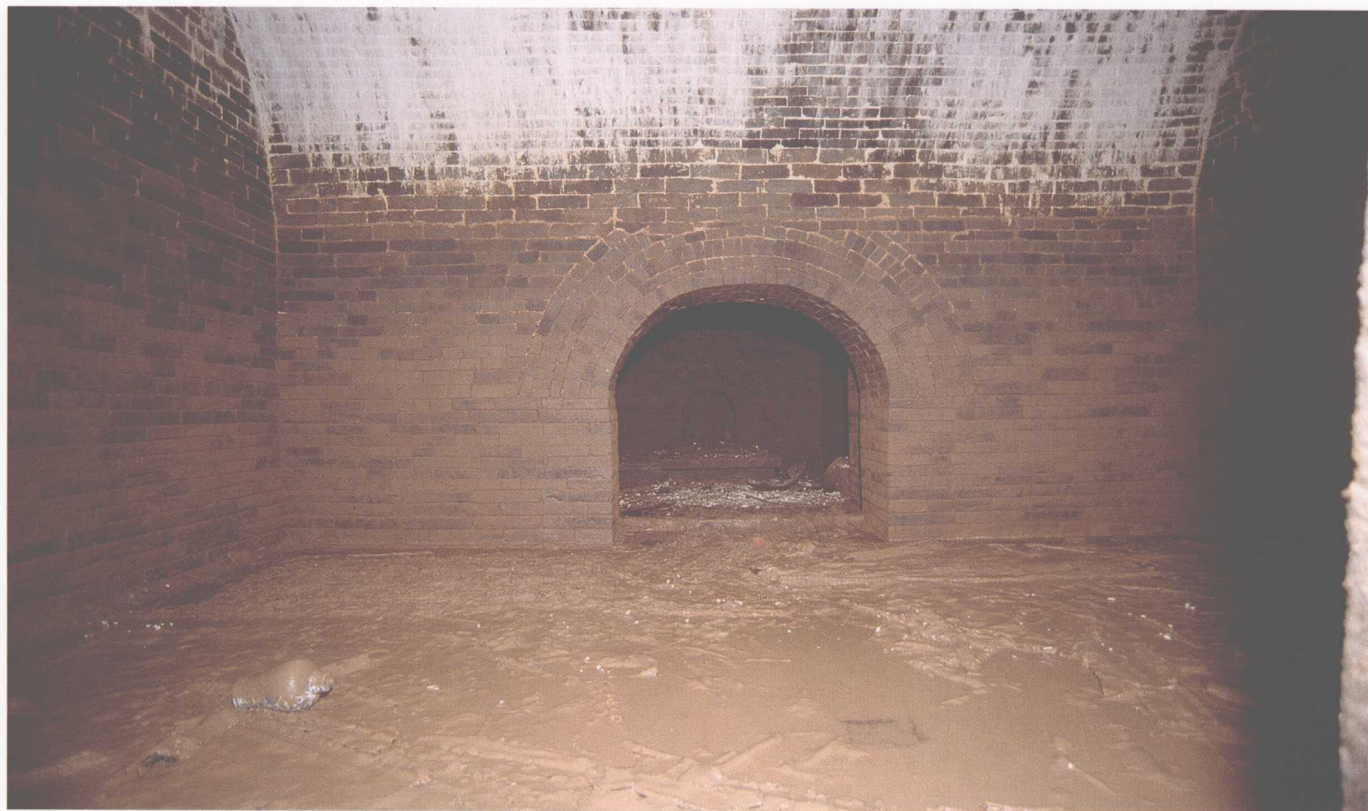
1. 中后部（正中为后室券洞，洞前方坑为“自来石”支垫坑）
