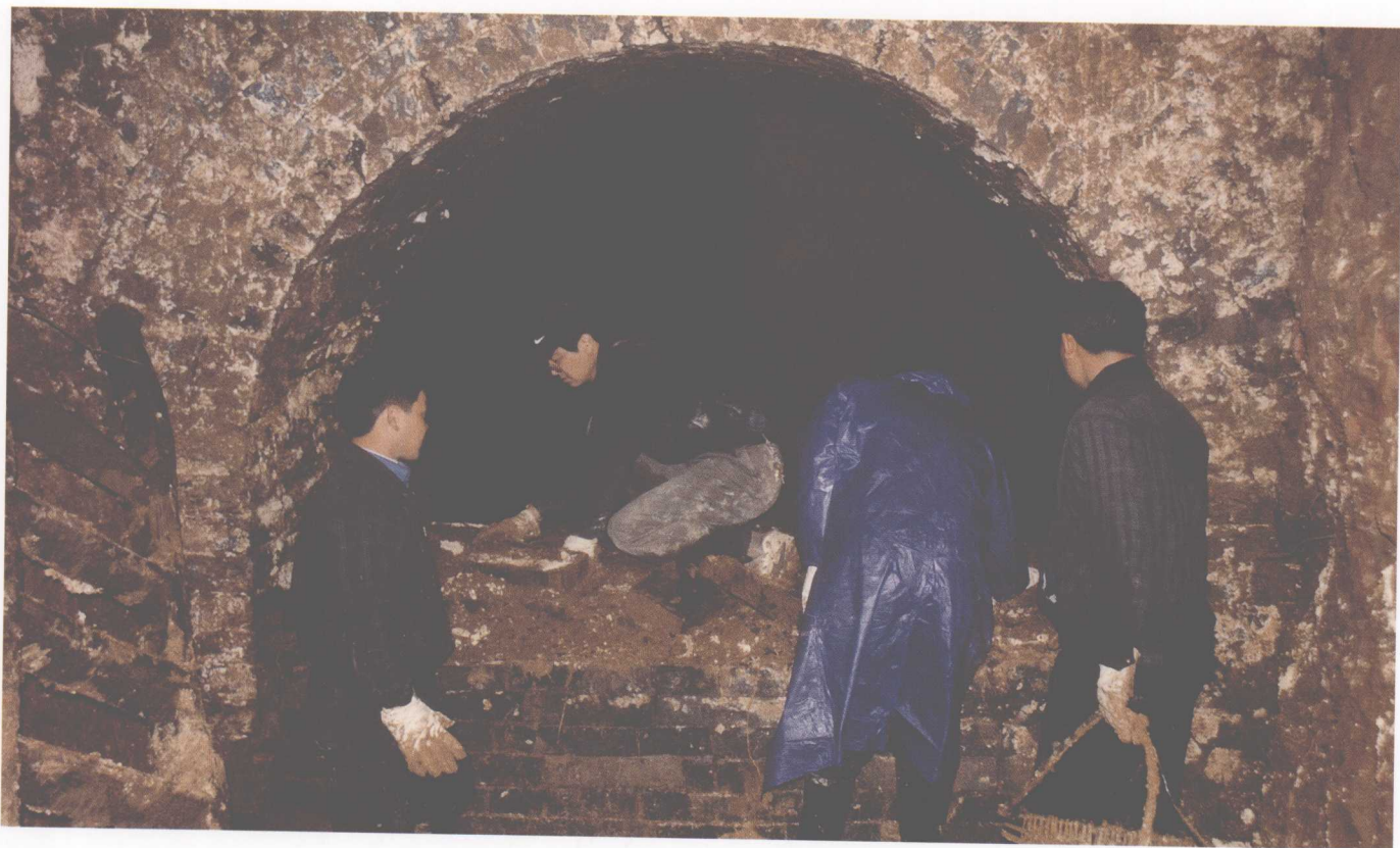
1. 拆除封门墙（南—北）
