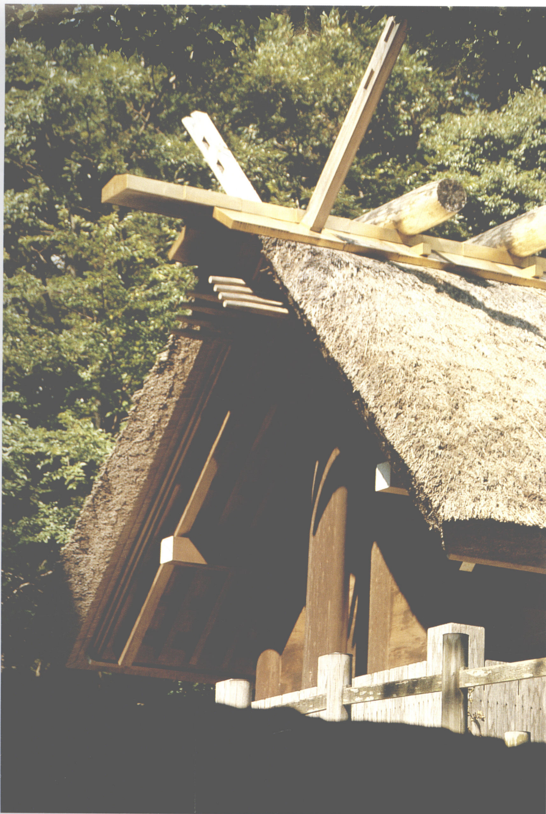
日本伊势神宫每隔 20 年重修一次，这种替造制度据说可追溯到 1500 年前。
