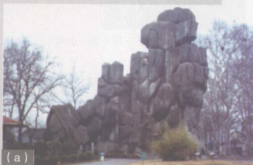
彩图 4-23 大体量钢骨架塑山 (结合鸟舍配置、大门布局) (江苏、陕西)
