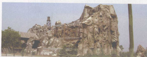
彩图 4-28 钢结构玻璃钢塑山 (矿山车游乐设施) (陕西)
