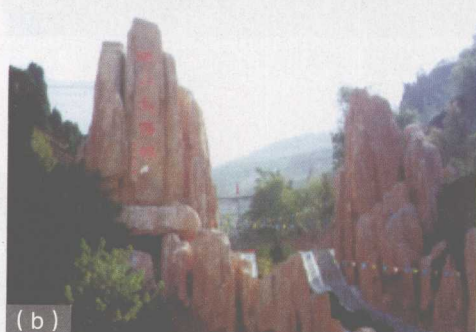
彩图 4-23 大体量钢骨架塑山 (结合鸟舍配置、大门布局) (江苏、陕西)
