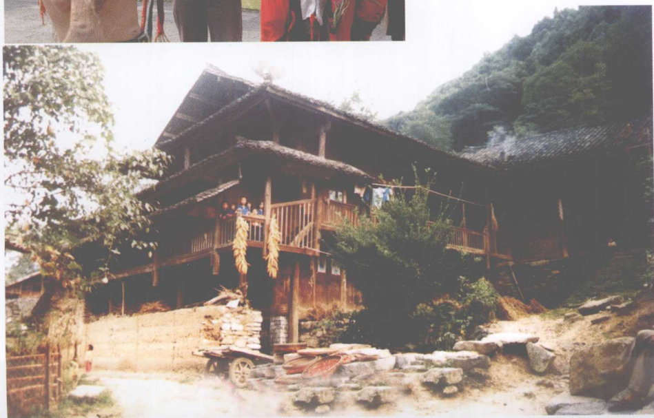
独具特色的秀山民居——土家吊脚楼
