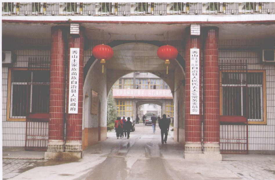
县政府、县人大办公大楼
