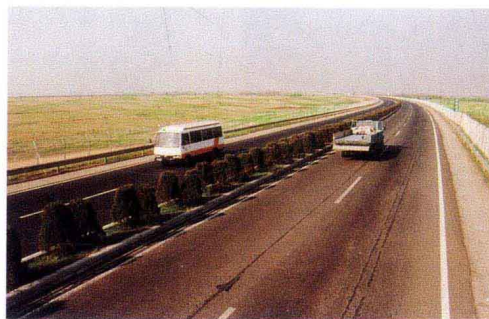
武汉岱黄高速公路俯瞰
