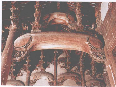
黄山八面厅门厅梁架
