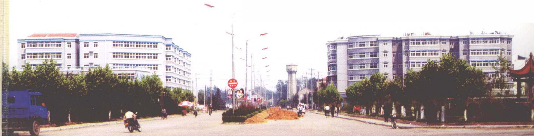
利用采煤塌陷地回填复垦的现代化城镇——徐州市贾汪区大吴镇
