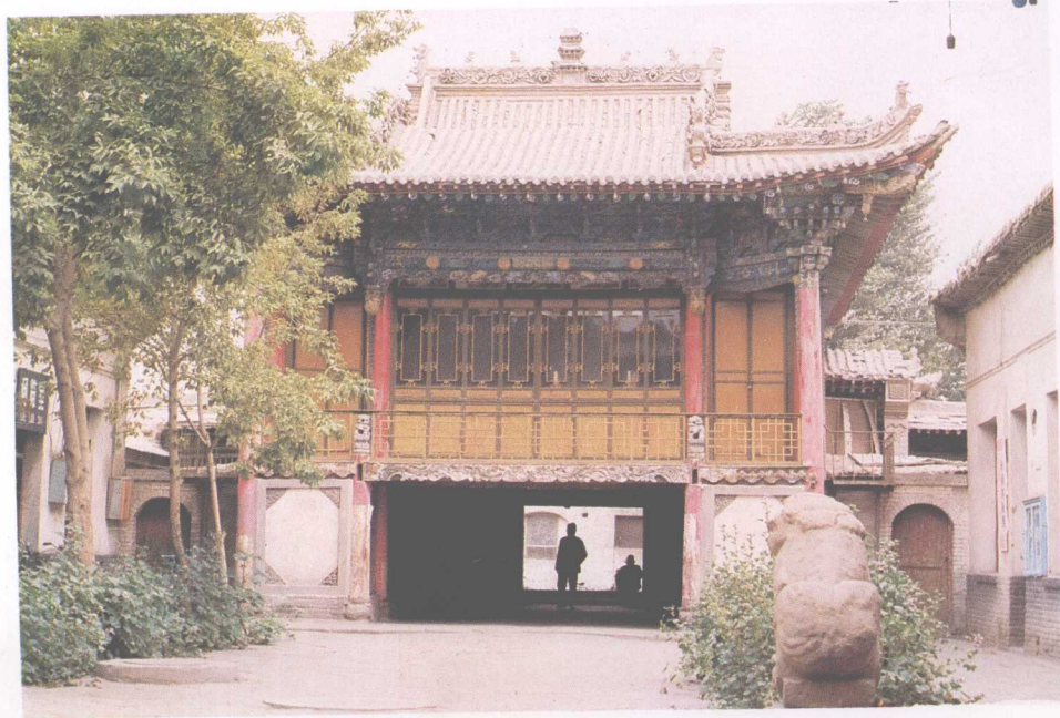
甘肃张掖山西会馆戏楼
