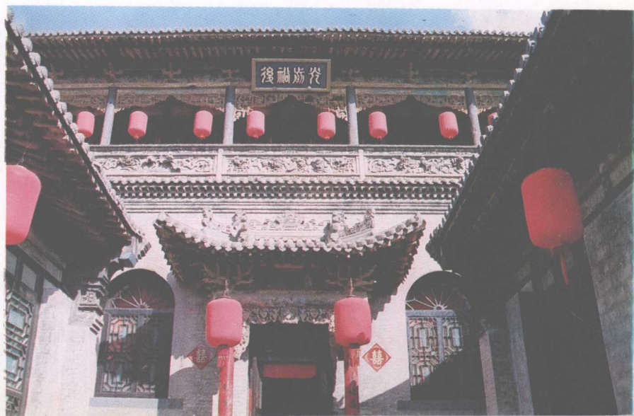
祁县大德通、大德恒票庄资本家乔致庸家大院后楼(张刚 摄)
