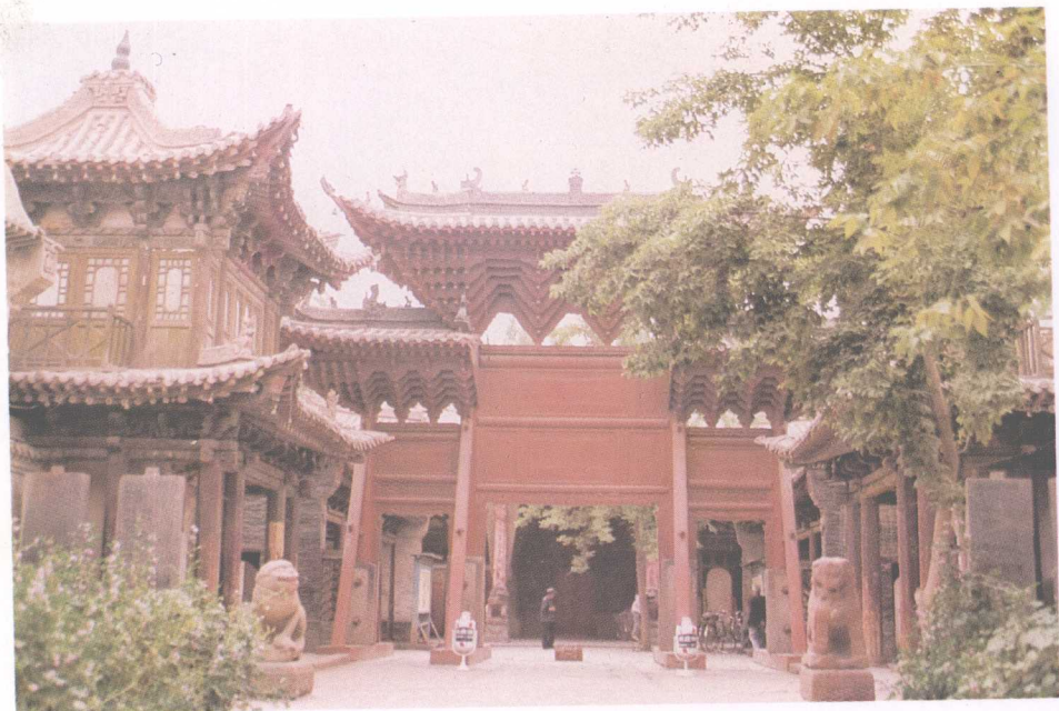
甘肃张掖山西会馆钟鼓楼及大牌坊
