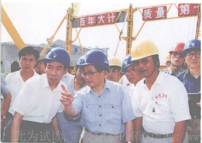
黄菊同志在内环线工地
