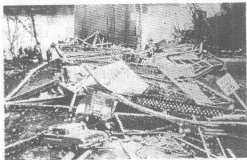
图 1.4 垮塌的 Point Pleasant 桥
