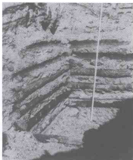
图版伍3、铜绿山战国竖井支护结构
