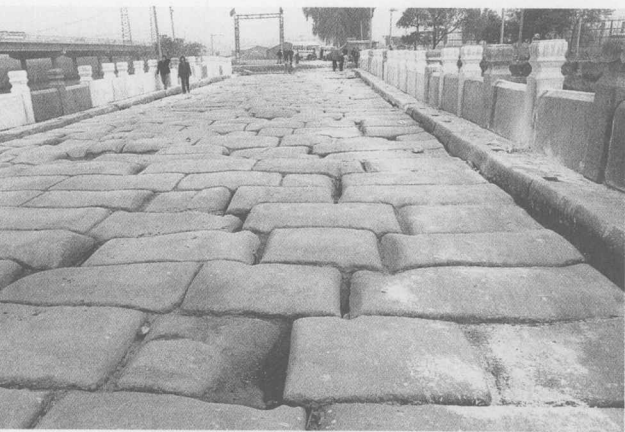
房山区琉璃河古桥 脚下的石板如硕大的鹅卵石
