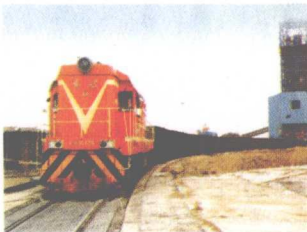
20万吨级铁矿专用码头装车系统
