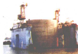
建造15万吨级码头用的预制圆筒
