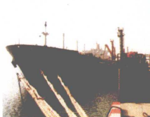
5万吨级液体化工码头
