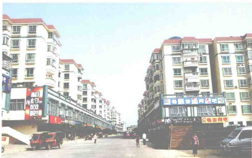
柳江县商贸街一期工程投入使用
