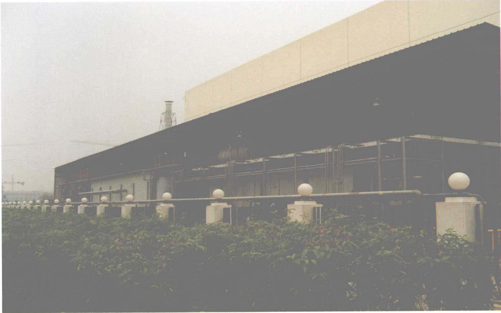
某电镀废水含氯、含铬废水处理系统
