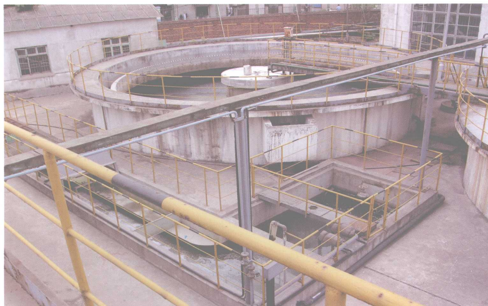
某厂电泳涂装废水水解池及出水堰
