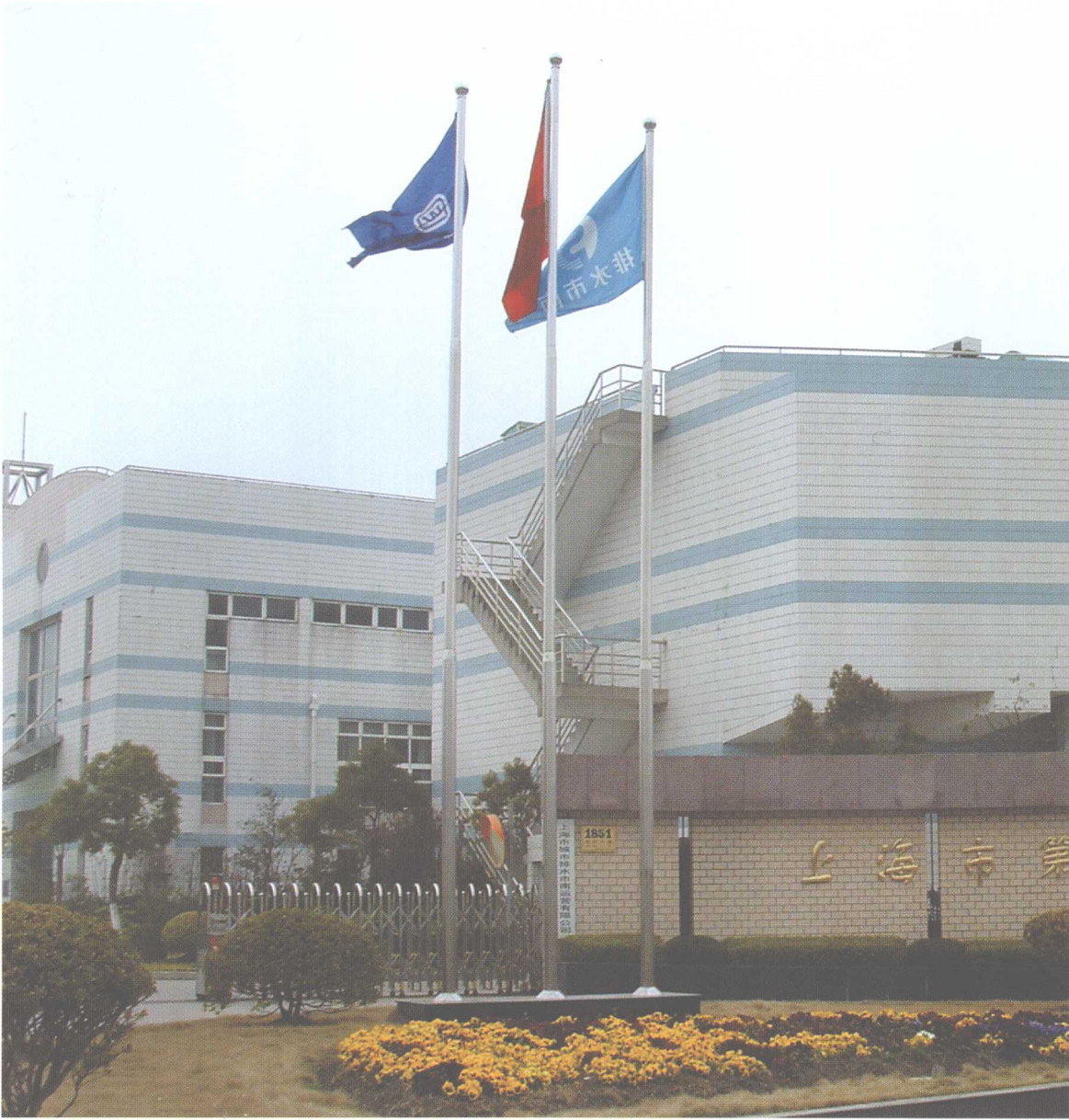
污水输送大型泵站一瞥
