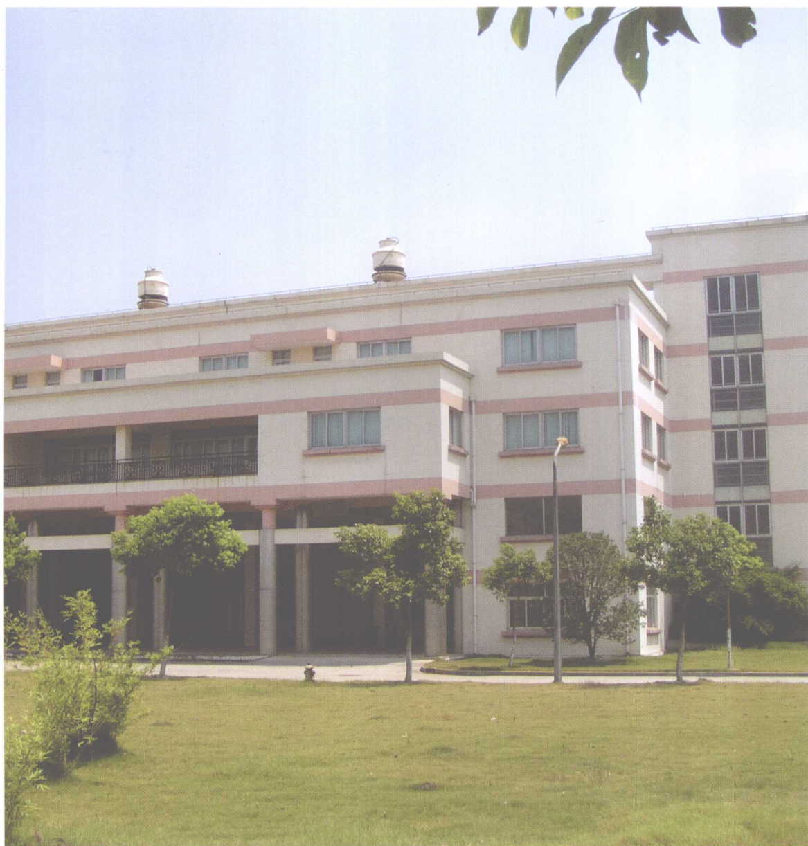
污水输送大型泵站一瞥
