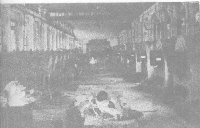
胸怀全局干革命，艰苦奋斗创新业。图为梧州锅炉厂工人在焊接快装卧式锅炉。
